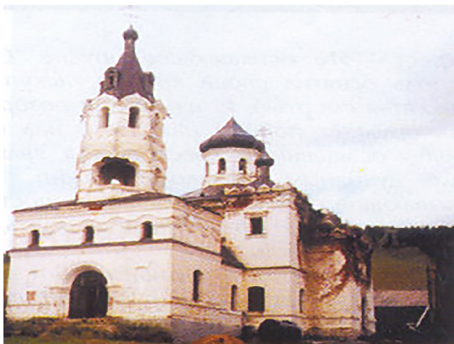
Рис. 12. Церковь в селе Курлыч Чернышевского района (до реконструкции)
